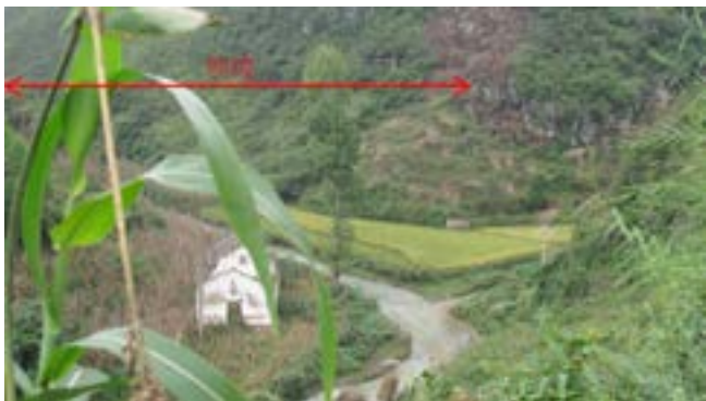
图1 下窑水库坝址河段、坝线
